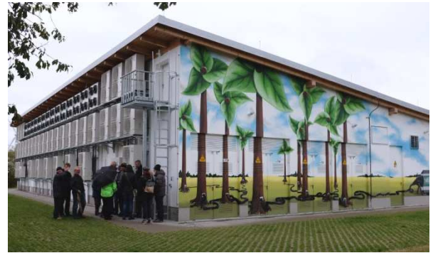
Herzstück des Energieparks: Der europaweit größte Batteriespeicher trägt mit 3.360 Speichermodule zur Sicherung der Netzfrequenz im Stromnetz bei.
