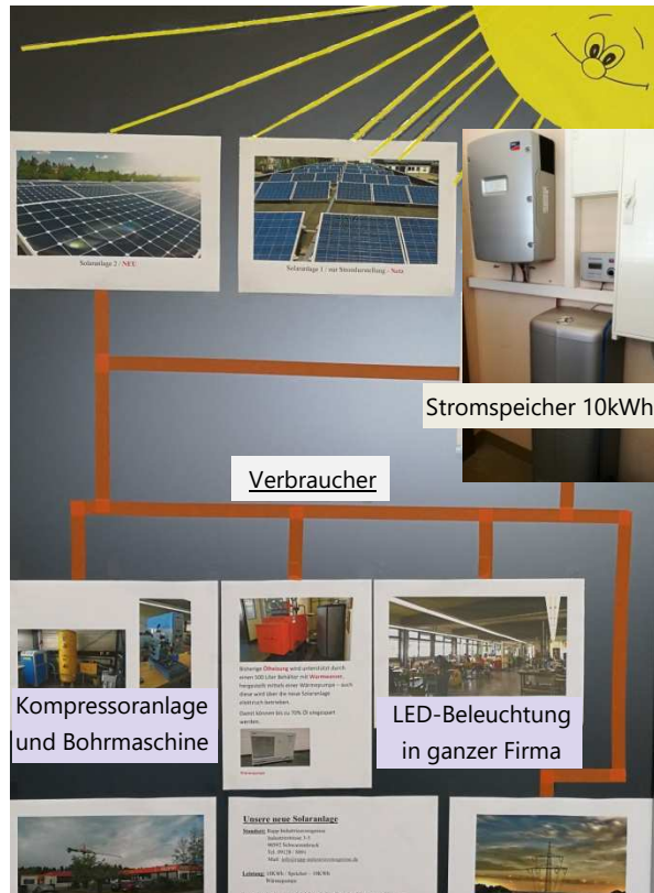
Fa. Rupp Industrieerzeugnisse, Schwarzenbruck, nutzt Strom von der Sonne direkt für die Produktion
