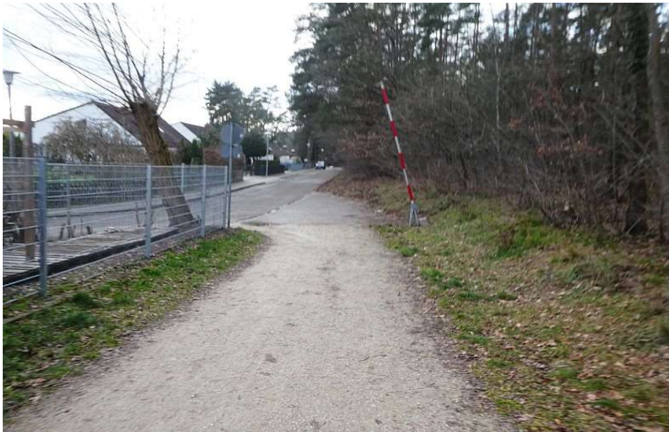
Friedhofszufahrt Blick Richtung Ginsterweg
